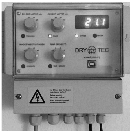
Abbildung 9 Absolutfeuchteregelelung für eine Kellerlüftung (© DRYTEC)
